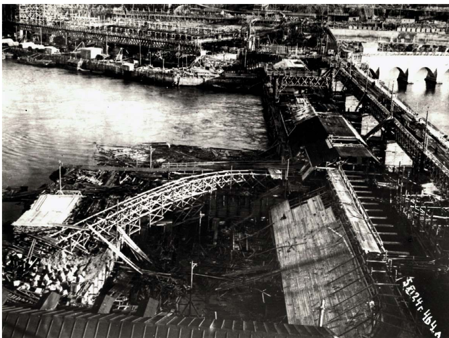
Общий вид строительства со стороны левого берега р. Волхов. 1924 г.
