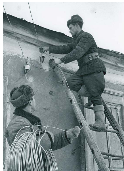
Фото 10. Электромонтёры заканчивают проводку в избе в с. Столбиче ТАССР. 1948 год
