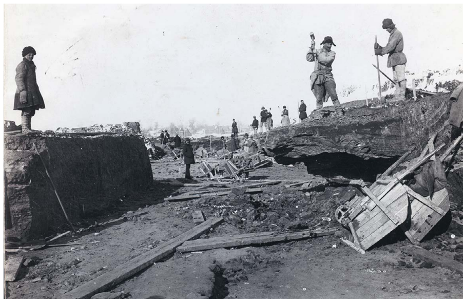
Начало строительных работ. Средства механизации — лопата, лом, кувалда. Транспортные средства — тачка, вагонетка
