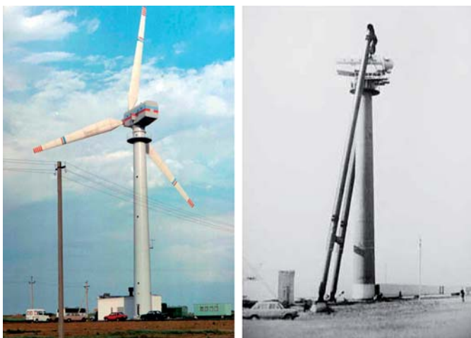
Фото 5. Ветроэнергетическая установка МКБ «Радуга» мощностью 1000 кВт Калмыцкой ВЭС и её монтаж с помощью «шевра»
