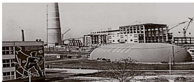
Фото 2. Воздухоопорное здание на строительстве Рязанской ГРЭС. 1975 г.
