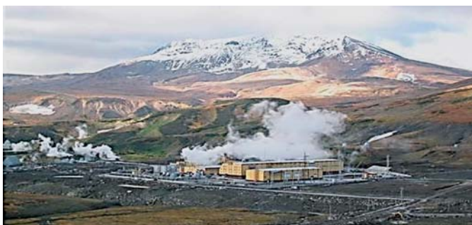
Фото 7. Мутновская ГеоТЭС на Камчатке мощностью 2 × 25 МВт
