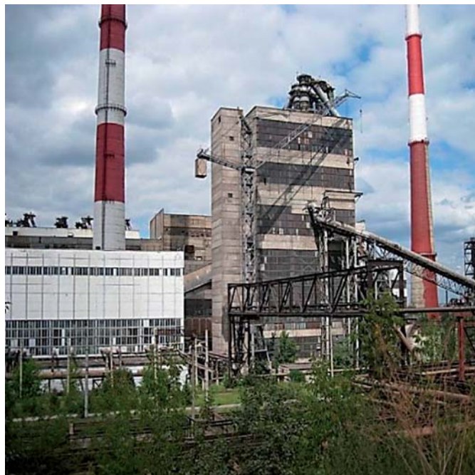
Фото 1. Установка ЭТХ-175 на Красноярской ТЭЦ-2
