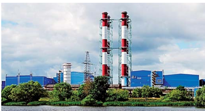
Фото 9. Ивановская ГРЭС, стенд испытания ГТД-110 (слева с белой трубой)
