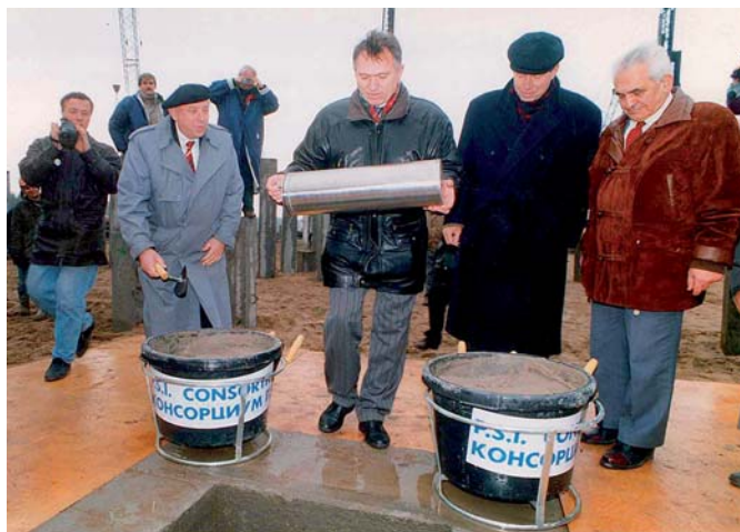
Закладка первого камня в основание Северо-Западной ТЭЦ. 28 октября 1994 г.
