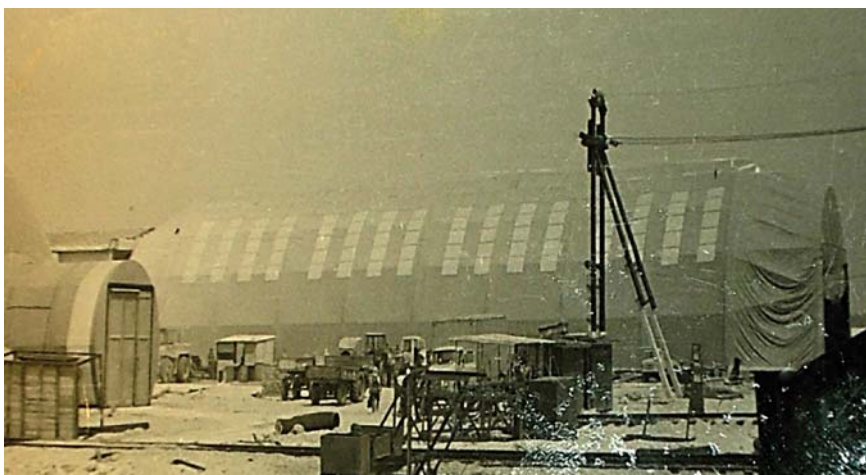
Обмуровочная мастерская площадью 1000 кв. м на Запорожской ГРЭС
