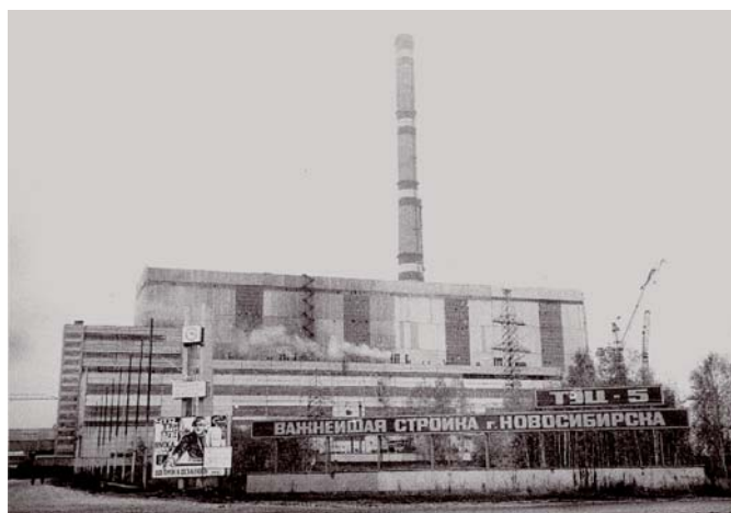
Накануне пуска первого энергоблока Новосибирской ТЭЦ-5. 1985 г.
