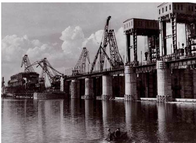
Новосибирская ГЭС — единственная на реке Обь. 1950-е годы
