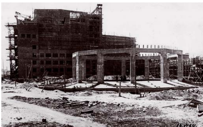
13 июня 1934 г. Строительная площадка Новосибирской ТЭЦ-2
