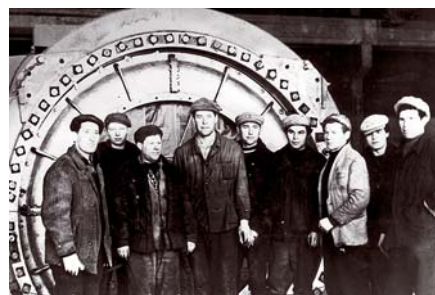
Бригада турбинистов-монтажников участка «Теплоэнергомонтаж»
