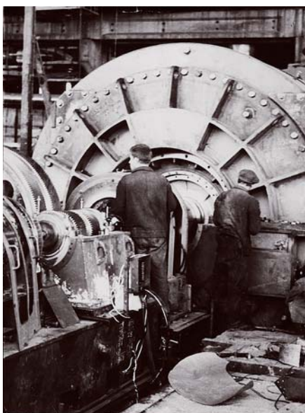
Монтаж генератора 1-го энергоблока Новочеркасской ГРЭС (1964 г.)
