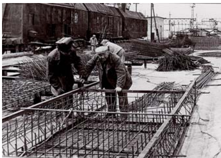
Подготовка подушки — основания главного корпуса (1964 г.)
