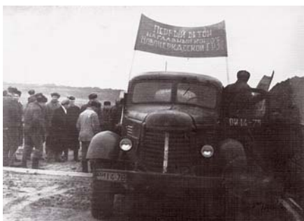
Заливка первого бетона в основание главного корпуса (1961 г.)
