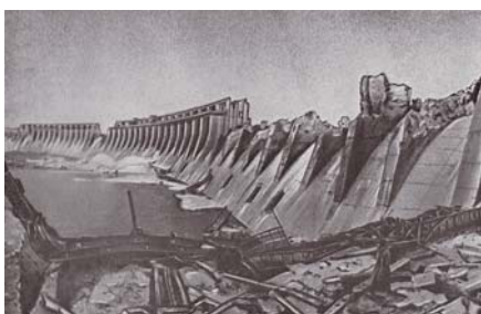
Разрушенная часть плотины Днепрогэса
