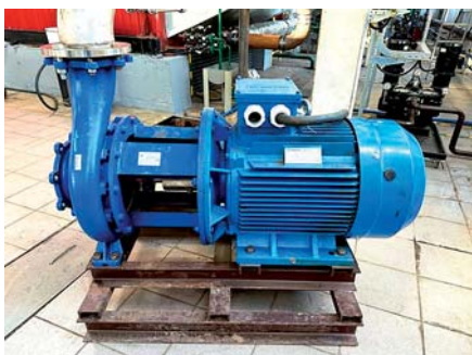
Химический насос производительностью 315 м 3 /ч
