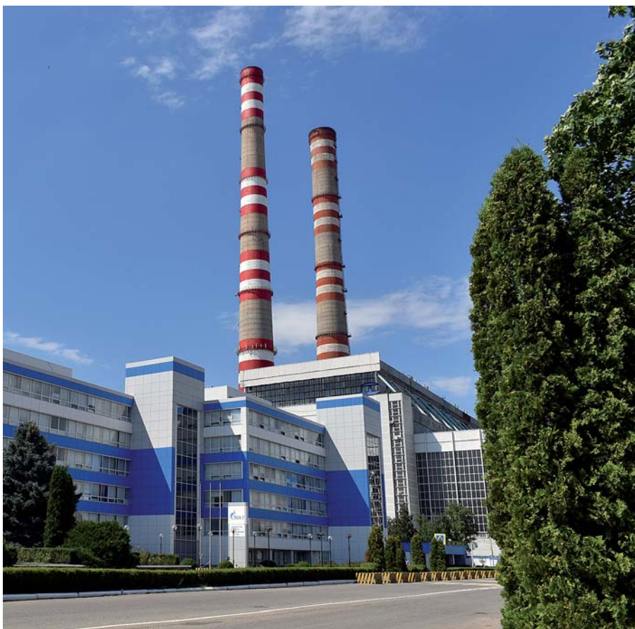
Здания инженерно-бытового и главного корпусов Ставропольской ГРЭС сегодня
