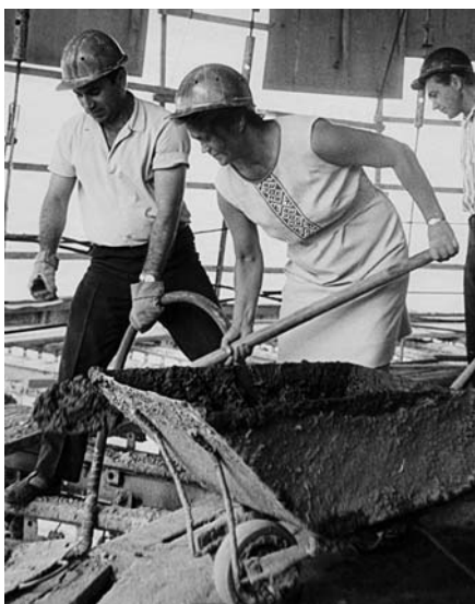
Закладка бетона в основание дымовой трубы № 1 Ставропольской ГРЭС. 1973 г., октябрь
