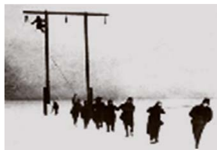
«Ледовая линия». Раскладка провода
