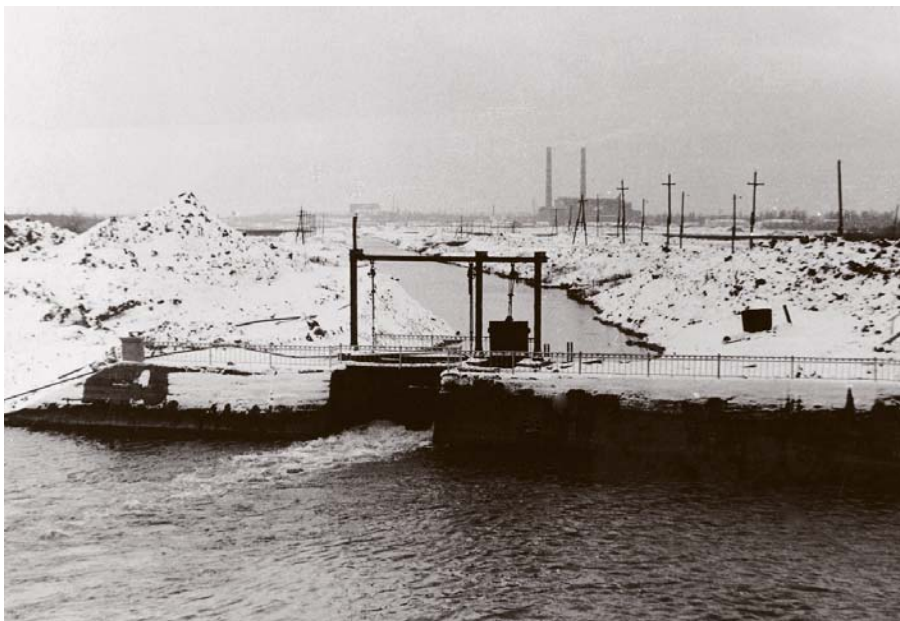
Серовская ГРЭС со стороны плотины, две трубы. Вторая половина 1950-х годов
